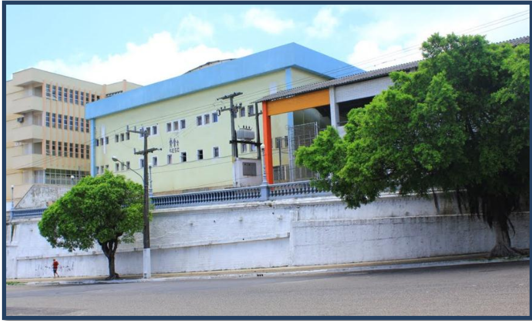
Muro externo do Sesc Cidade Alta, na Av. Câmara Cascudo
